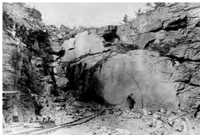
Einsiedlerfelsen mit aufgezeichnetem Tunnelprofil
