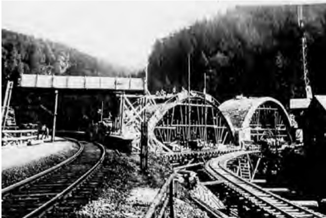
Brücke in Floßplatz
